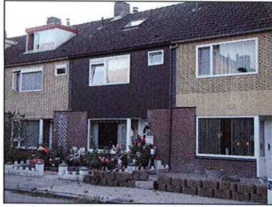
Houten gevel is vervangen door baksteen, dat ook al onderdeel van het gebouw was. Kozijnbreedte van begane grond en verdieping zijn goed in samenhang.
