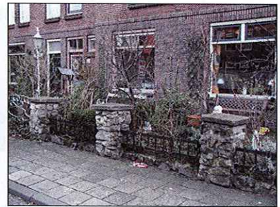
De standaard erfafscheiding bij de bouw, vormt nu een karakteristiek element dat voor samenhang zorgt.
