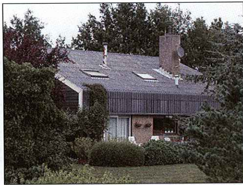
Bedrijfswoning met eenvoudige rechthoekige hoofd- vorm onder zadeldak waarin het materiaal refereert aan dakbedekking van de bedrijfsschuur.
